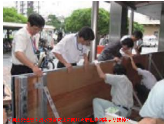
木の止水板を設置
