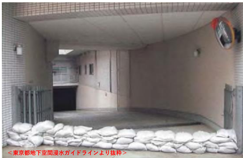
土のうを設置
