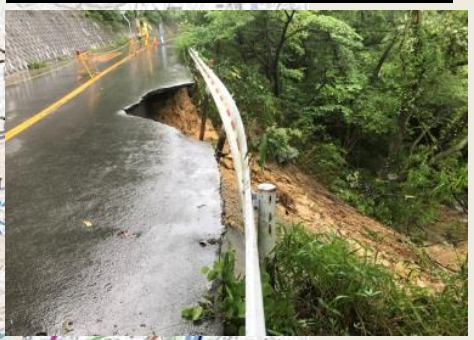
萩谷西五百住線 法面崩壊(高槻市萩谷月見台)
