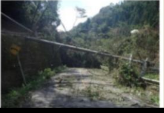
芥川両国橋下流:河道内倒木 (高槻市出灰)
