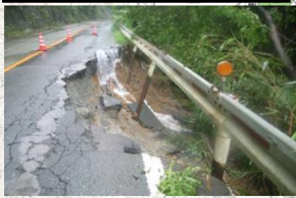
萩谷西五百住線 法面崩壊(高槻市萩谷月見台)
