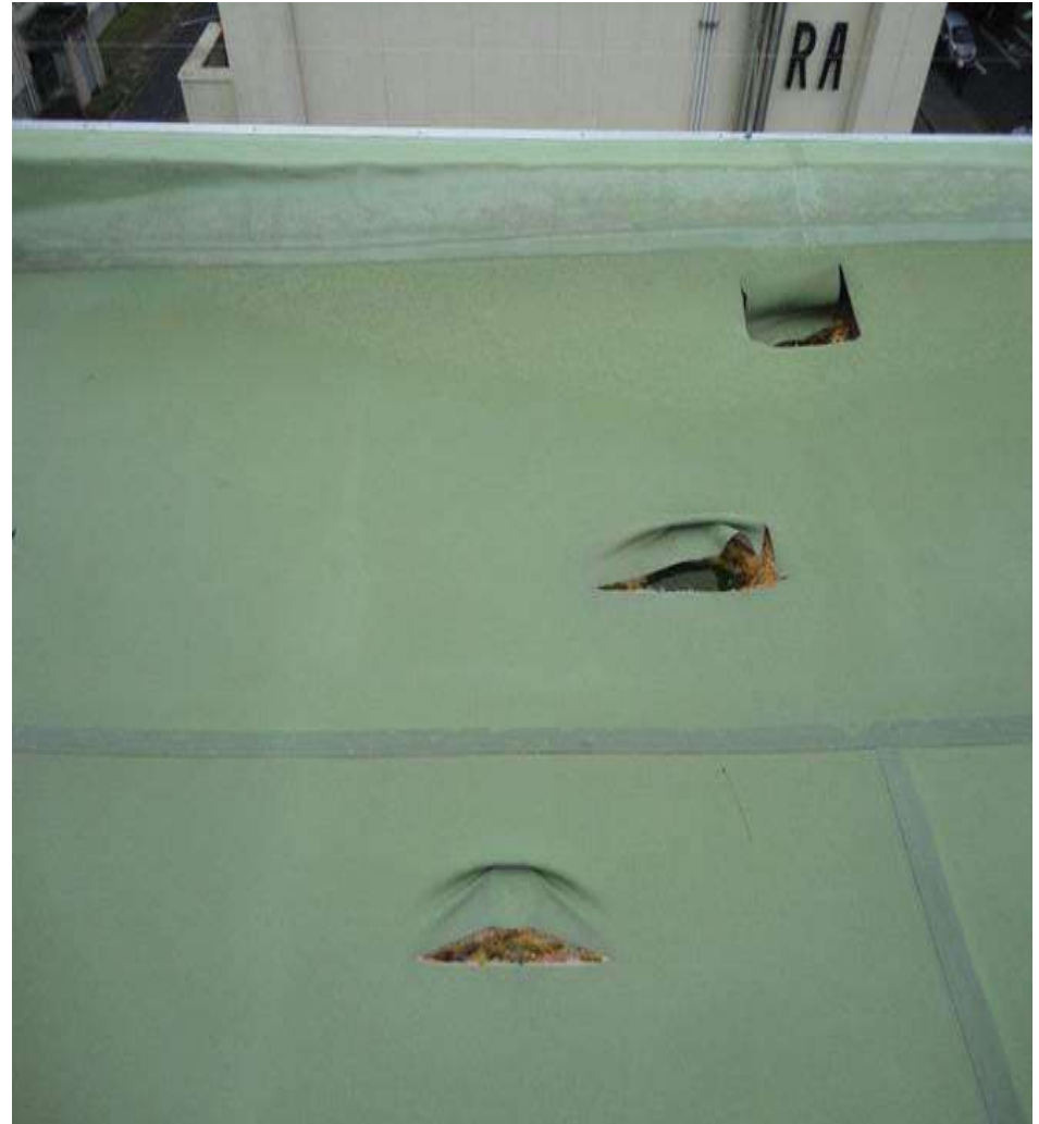
ディスク周りでの破断
