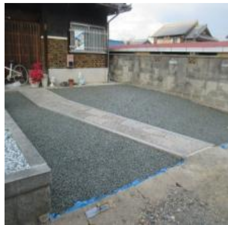
下地舗装(6号碎石)
