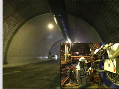
トンネル (セントル・フィルム工法)
