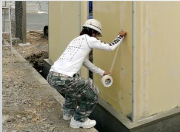
ファイバーテープ貼り (接合部・ボルトパッキン部)
