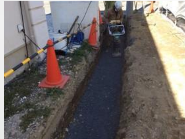
砕石転圧 (ランマー等で転圧)
