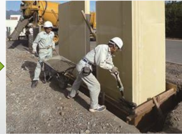
根巻きコンクリート
