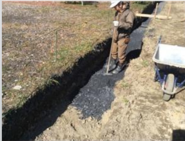
床付け・砕石敷き (C40クラッシャーラン)
