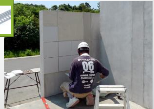
仕上げ 写真はタイル張り (接着剤貼り)
