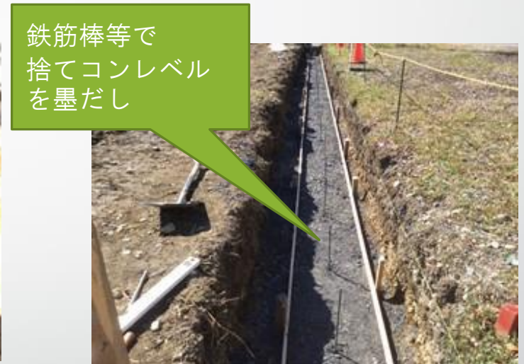
捨てコン堰板設置
