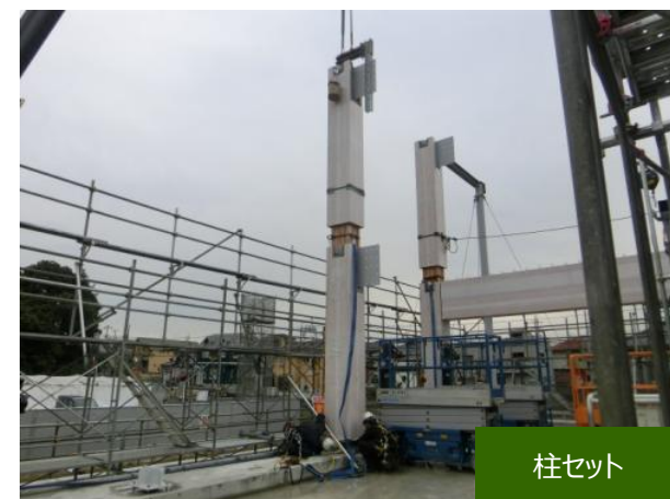
工 事 名 新柏クリニック 新築計画 工 種 燃エンウッド工事 09 燃エンウッド 会社 柱脚部金物
