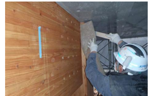
柱梁隙間へのロックウール挿入
