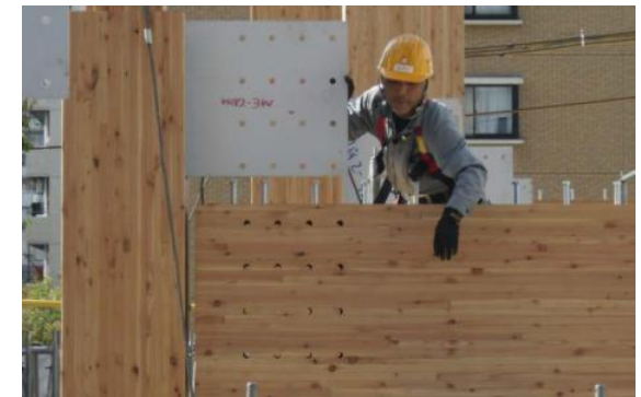
柱梁隙間へのロックウール挿入
