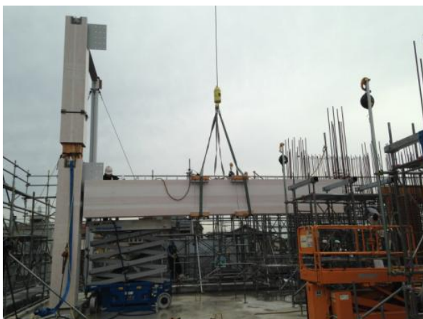
梁取付 (下から差し込み)
