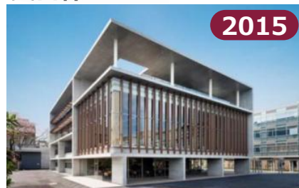
横浜商科大学高等学校 実習棟
