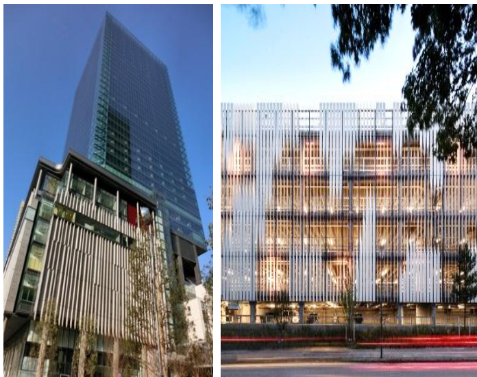
事例1：ビル・駐車場の壁面
