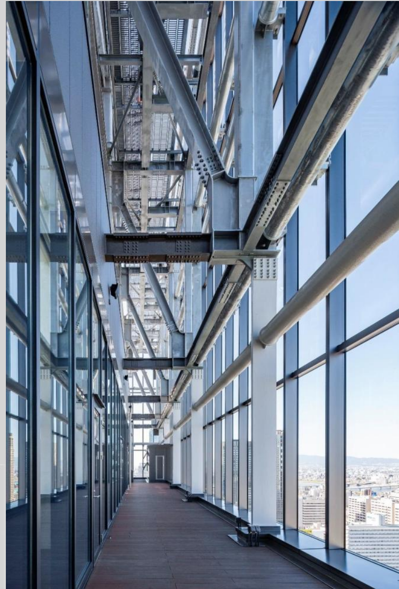
カーテンウォール吊材 吊端部
