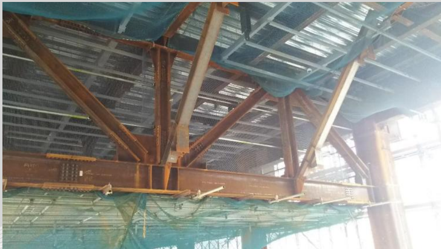
ホール上部トラス梁部分
