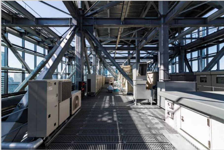
屋上ハットラス部分
