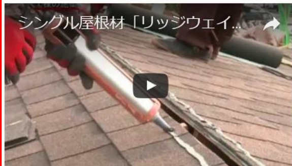
シングル屋根材「リッジウェイ」の施工方法
