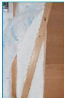
筋交いに沿ってグラスウールに切り込みを入れ、グラスウールを筋交いと同面に盛り上げます。
