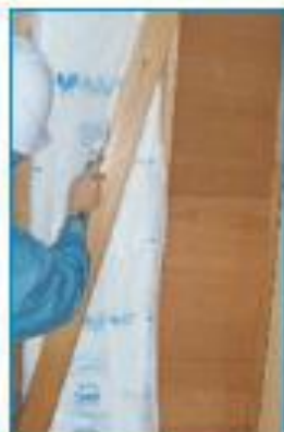
少し持ち上げて筋交いに沿ってフィルムをカットします。
