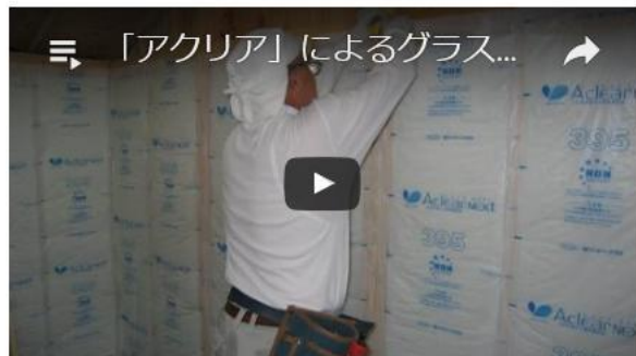
グラスウール断熱材「アクリア」の施工方法
