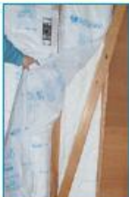
グラスウールを筋交いの後ろに充填します。
