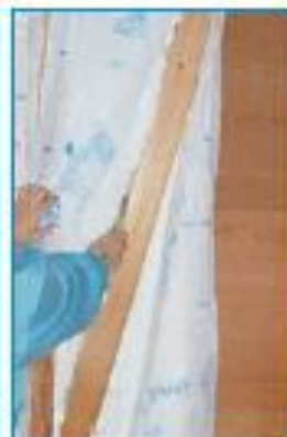
位置を戻しフィルムをめくり、筋交いに沿ってグラスウールに切り込みを入れてグラスウールを筋交いと同面に盛り上げます。
