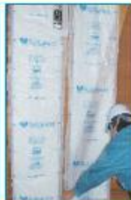
防湿フィルムを戻しタッカーで留めます。
