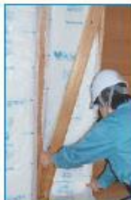
位置を戻しフィルムをめくり、筋交いに沿ってグラスウールに切り込みを入れてグラスウールを筋交いと同面に盛り上げます。
