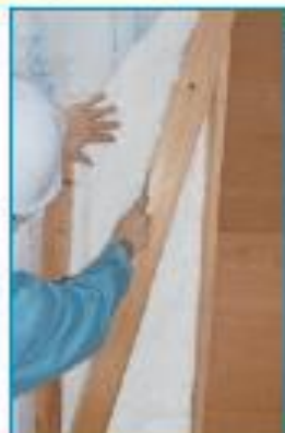
筋交いに沿ってグラスウールに切り込みを入れ、グラスウールを筋交いと同面に盛り上げます。
