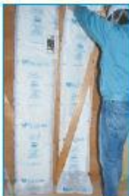
少し持ち上げて筋交いに沿ってフィルムをカットします。
