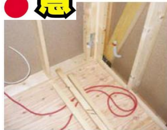
根太床 (根太が土台・大引と平行している場合)
