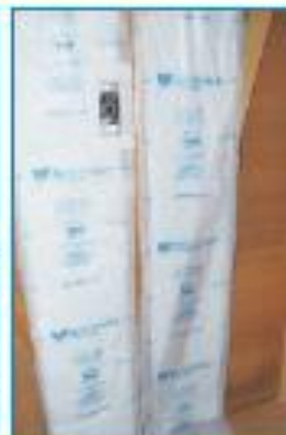
防湿フィルムを戻しタッカーで留めます。
