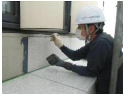
⑤目地処理(目地幅5m/m)
