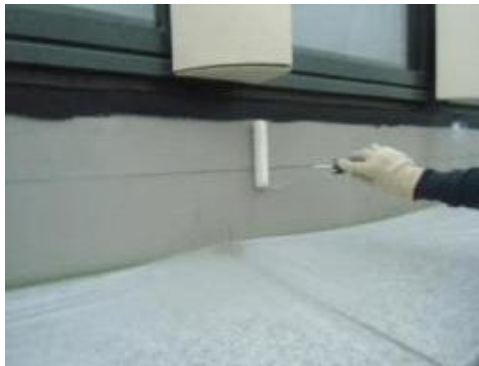
⑤目地処理(目地幅5m/m)
