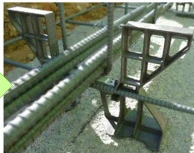
当社は、工場で発生する外壁面材の廃材を微粒子レベルまで粉碎し、リサイクルプラスチックと混ぜ合わせることで、より、曲げ・圧縮強度に優れたリサイクルプラスチック製品を開発しました。基礎鉄筋を適正に配置する「基礎スベーサー」に適用し、これまで処理費用がかかっていた外壁面材の廃材を素材としてリサイクルすることで、環境に優しいだけでなくコスト削減を図ることが出来ます。
