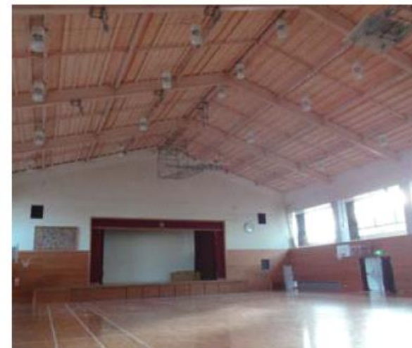
天井撤去工事施工後の状況
