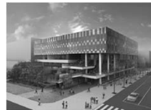
耐火建築物の事例 (東部地域振興ふれあい拠点施設)
