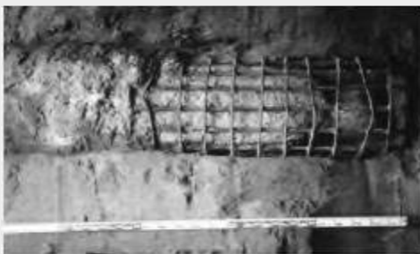
ピア杭の先端部の一例
