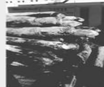
腐食していない木杭
