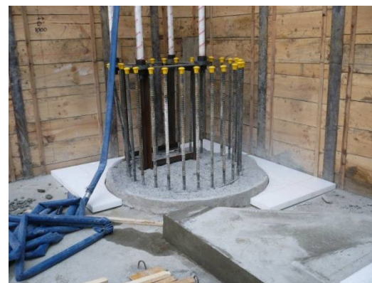
杭のフーチン底部
