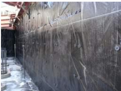
(5) 大型止水リング取り付け
