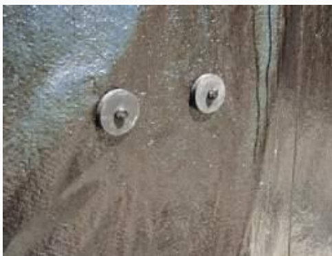
(5) 大型止水リング取り付け
