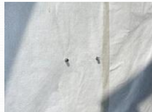
(3) レンペキルーフ張り付け
