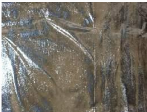
(4) ガスファルト吹付け
