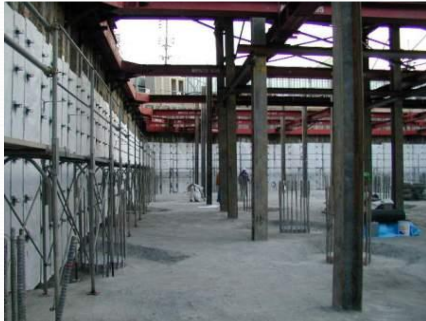
SMW連続壁面に下地材を張り付けた様子。
