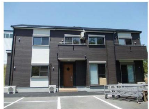
図2 住宅実験棟全景
