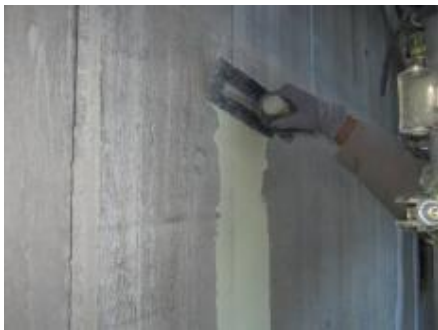
弾性下地調整材塗付け
