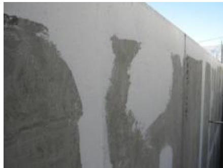
下地調整状況
