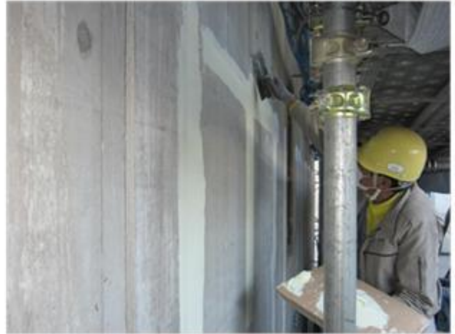
弾性下地調整材 塗付け状況
