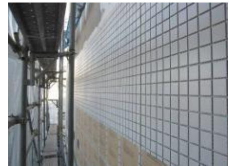
タイル張付け状況
