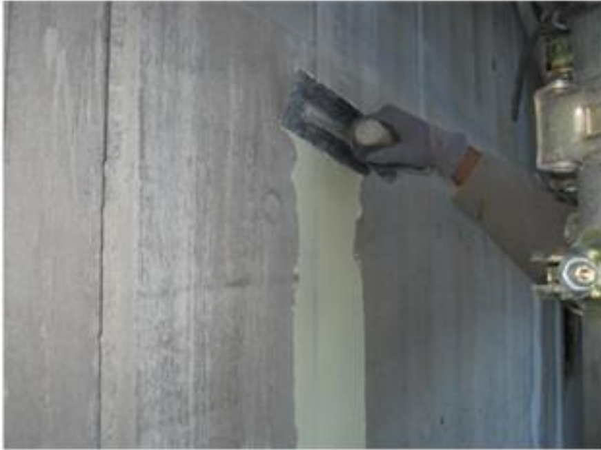
弾性下地調整材 塗付け状況
