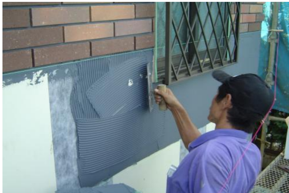
タイル張り用接着剤施工の様子
