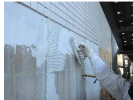
タイル張り用接着剤塗付け
