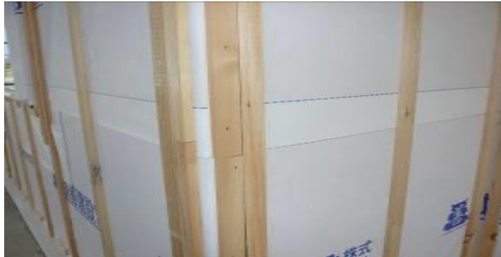
下地胴縁の不適切な施工
