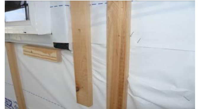
下地胴縁の不適切な施工
