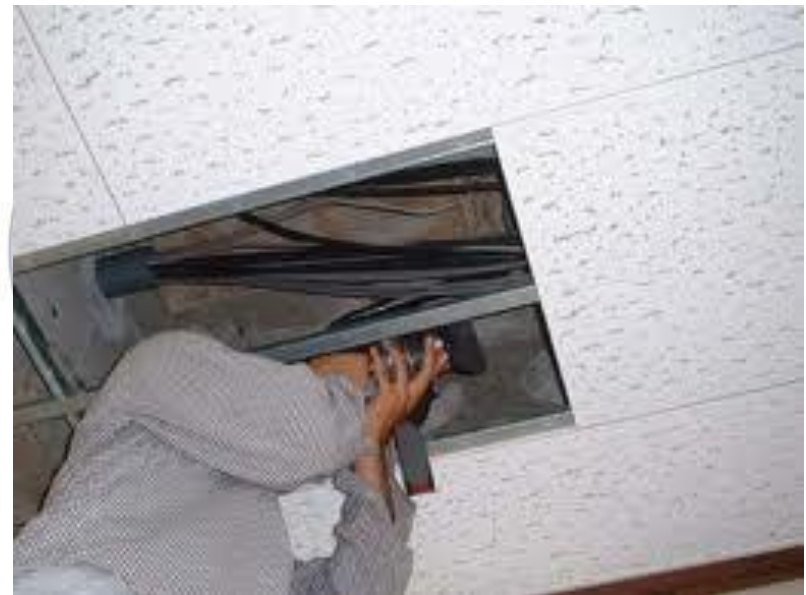
天井材料施工中
