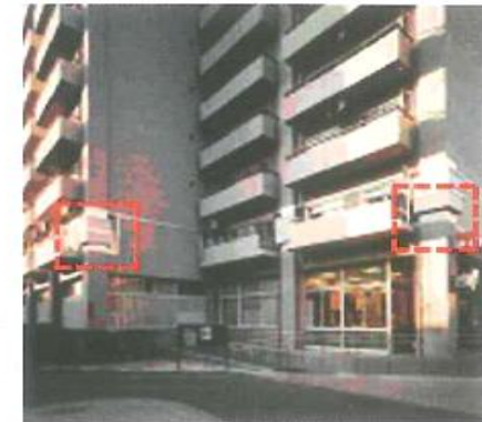
共同住宅の2階柱に免震装置を設置した例
