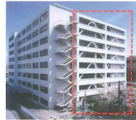
外側に制震ダンパーを組込んだ鉄骨ブレースを設置した例
