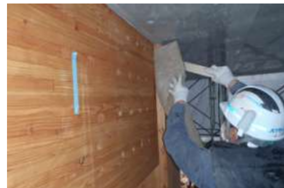
柱梁隙間へのロックウール挿入
