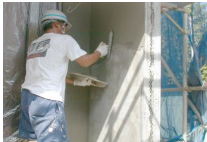
軽量モルタルの塗り付け
