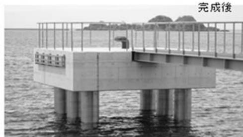
塩害環境におけるコンクリート構造物に採用されたステンレス鉄筋SUS410SD
