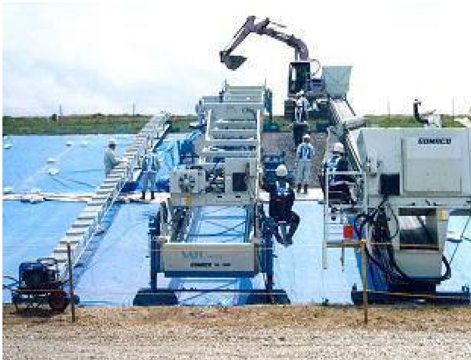
河川護岸の自動化された施工例
