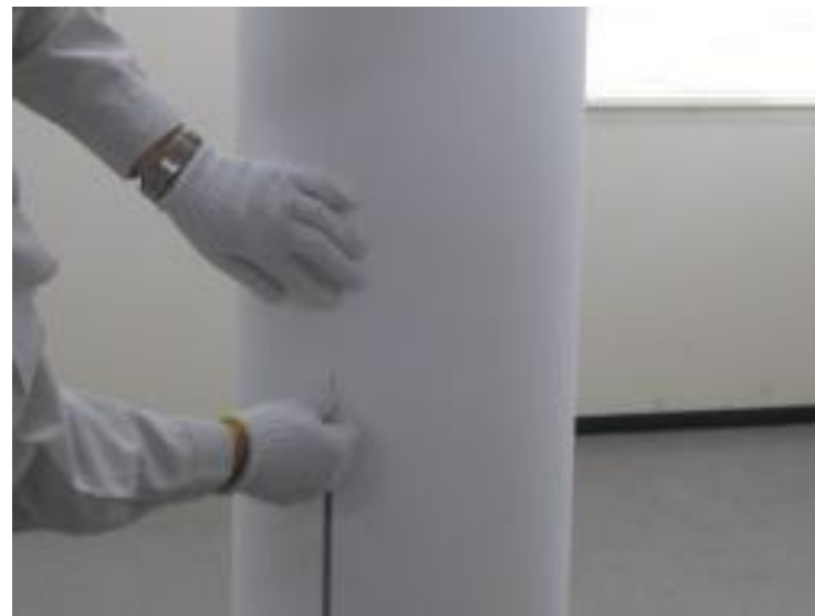
目地にシートを挿入する。
