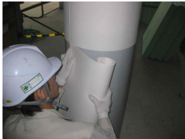
⑥順次、横目地に合せ、シートを貼る。
