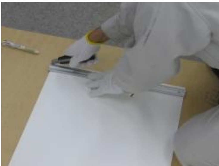
シートを目地幅に切断する。
