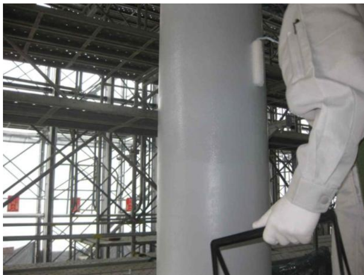
①ボンドをローラーで塗付し、指触乾燥まで放置する。
