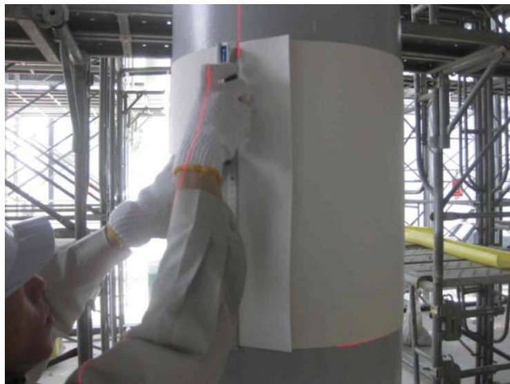
③シート端部は、1mm以下程度開け、切断する。
