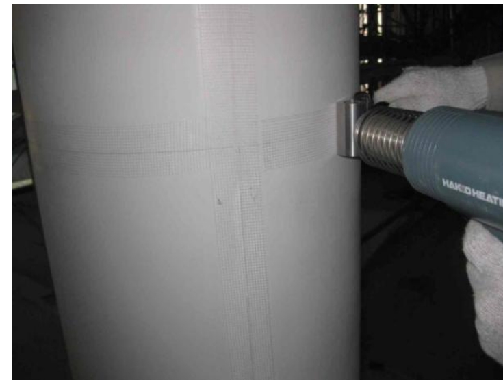
⑩ヒートガンで加温し、ローラーで融着する。
