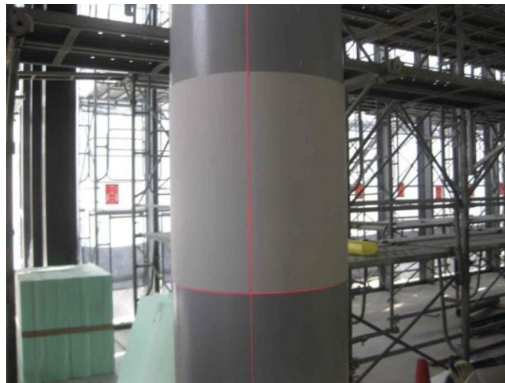
④シート端部は突合せとする。
