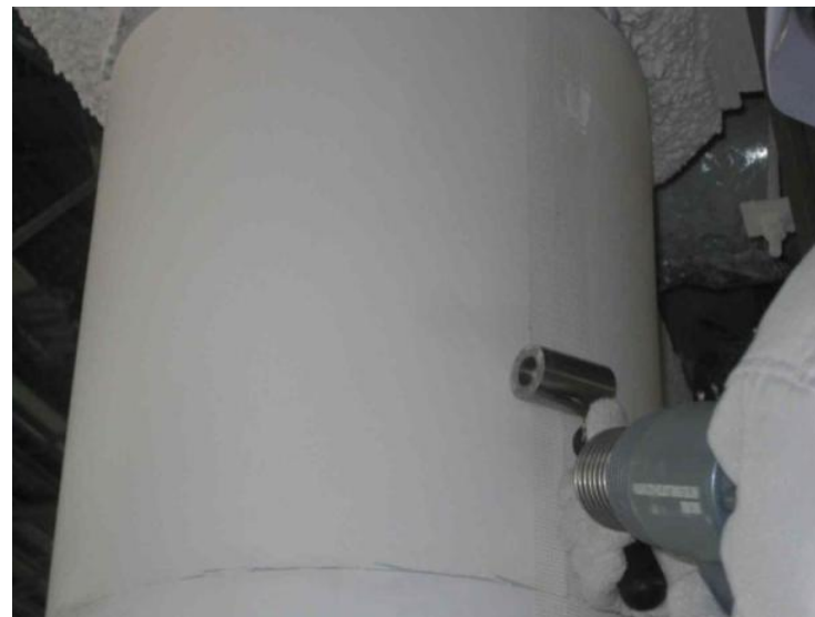
⑧ヒートガンで加温し、ローラーで融着する。
