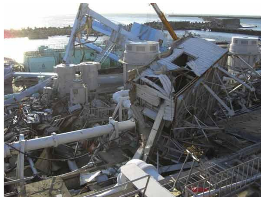
原子力発電所 海水ポンプ施設
