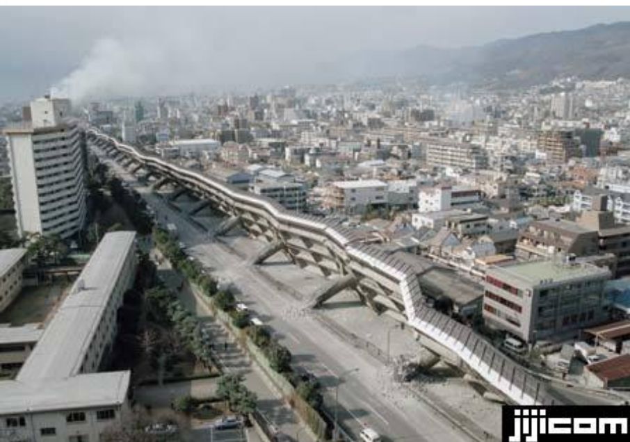
高速道路橋脚
