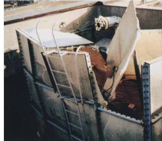
(b) 水槽天板の破壊
