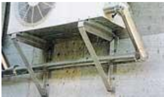
(a) 棚取付け
