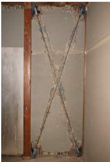
土壁を残して(半間)
