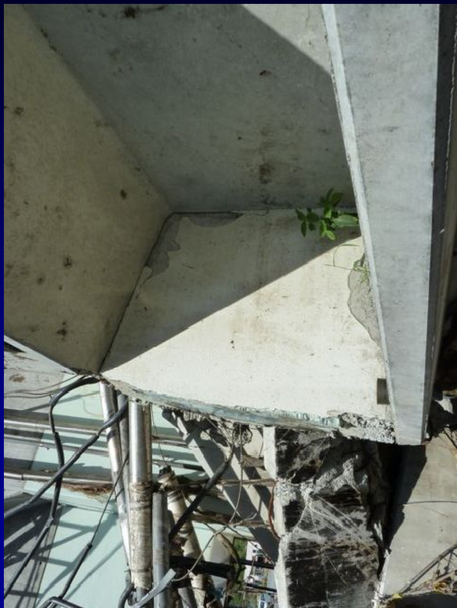
DT版端部の塞ぎ板
