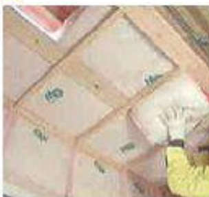
③ 外壁との取り合い部及びアクリアマット同士をよく突き付け、すき間が出来ないように施工します。
