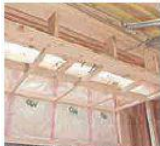
① 外壁を先行して断熱し石こうボードで押さえ、その後下がり壁と野縁を造作します。
