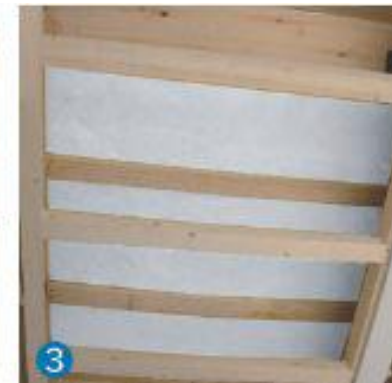
③ 下からアクリアUボードを施工します。
