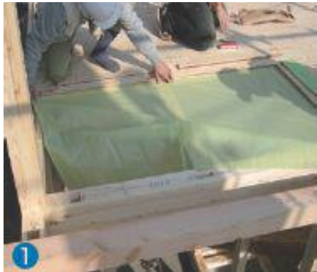
① 床下地材を張る前に防湿シートを施工します。
