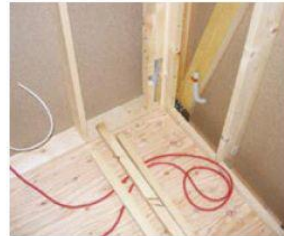
根太床 (根太が土台・大引と平行している場合)
