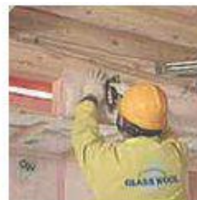
④ 下がり壁部分にも寸法に合わせてカットしたアクリアマットを充填します。
