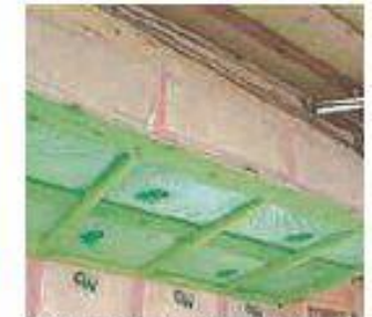
⑥ 天井部分に防湿シートを施工します。(写真の防湿シートは合成です)
