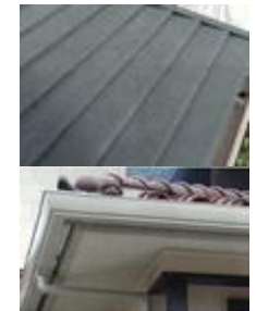
屋根・防水の 耐久性向上
