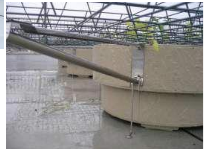
固定金具（オプション）取り付け
