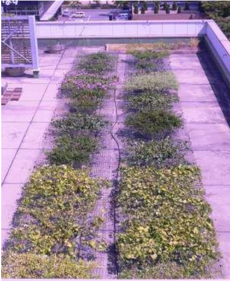
弊社R&Dセンター屋上全景
