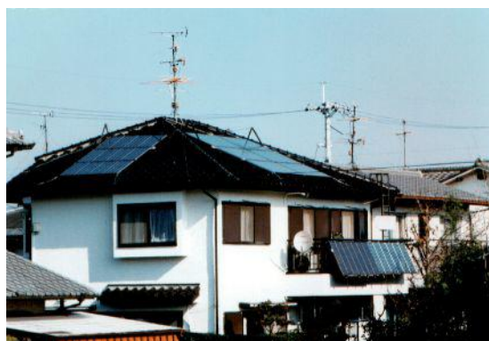
図20 日本初の個人住宅用逆流あり太陽光発電システム
