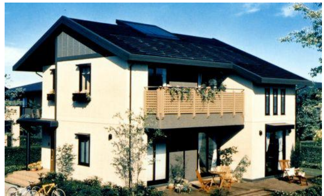
図25 建材一体型太陽電池設置例
