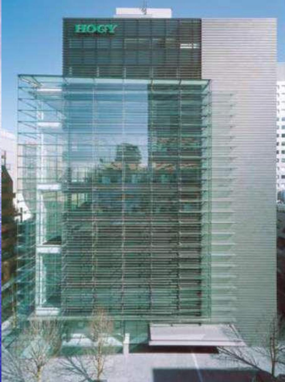
高透過ガラスと通常フロートガラスの中間の透過度のある半高透過ガラスを使用。ダブルスキンでありながら、透明度の高い（緑色の少ない）ファサードを構成している。ガラスリブを横使いし、シールの剪断力でガラスを支持するとともに、地震時の水平力をガラスリブで負担している。
