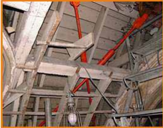
屋根鉄骨ブレース補強 Reinforcement of steel-frame roof bracing
