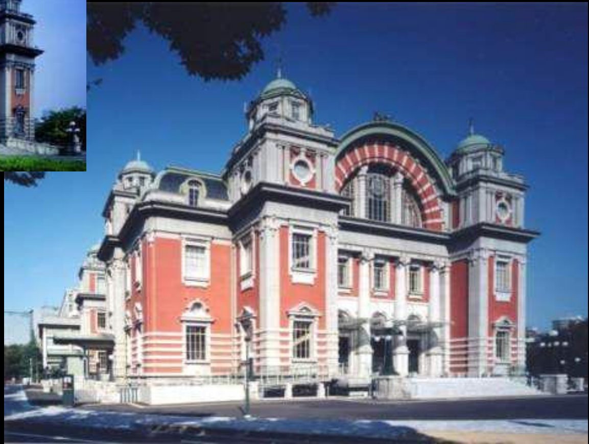
正面外観(工事前・後)
