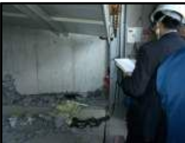
建物危険度判定
