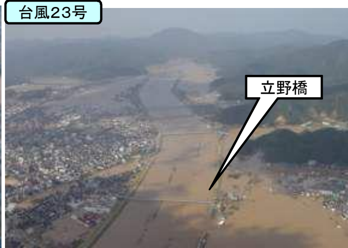
円山川立野付近破堤箇所
