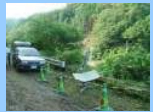
H18.7 兵庫県篠山市篠山南線土砂崩れ ・兵庫県庁 ・柏原土木事務所
