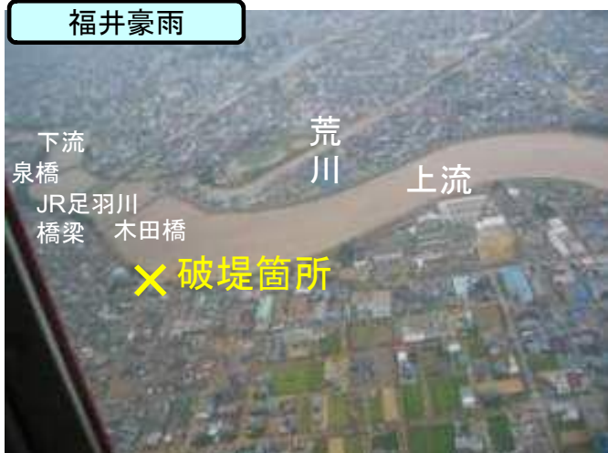
木田橋付近破堤箇所
