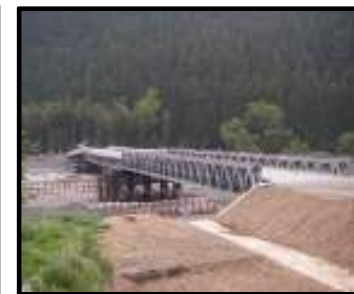
応急組み立て橋
