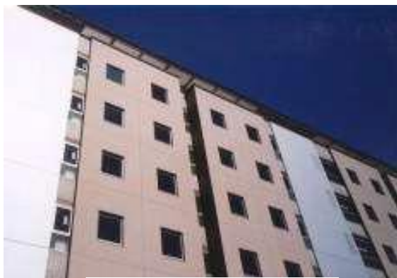
太陽光電池を組み込んだ庇
