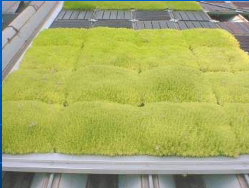
セダム(メキシコマンネングサ) (『ファイングリーン』標準仕様)
