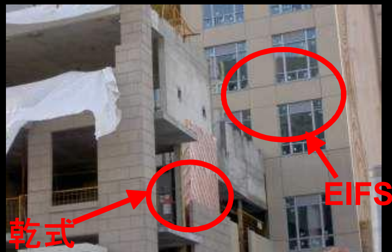
乾式工法とEIFSの併用
