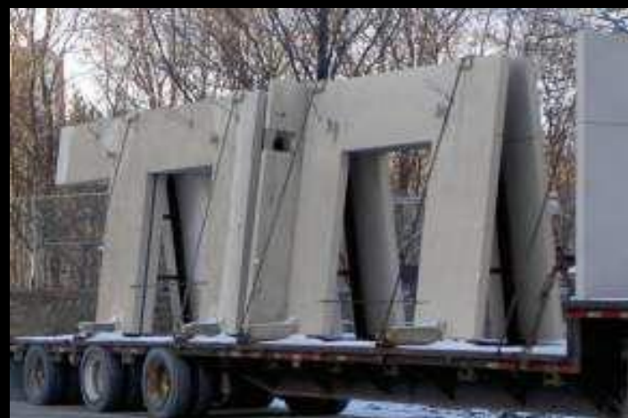
パネライズシステムで工場生産されたEIFS。仕上げまで施されている。
