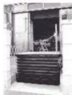
外出を助けるリフトを設けた例
