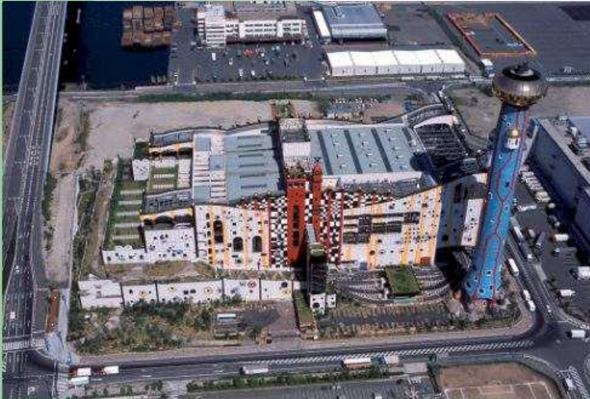
大阪市環境事業局舞洲清掃工場
