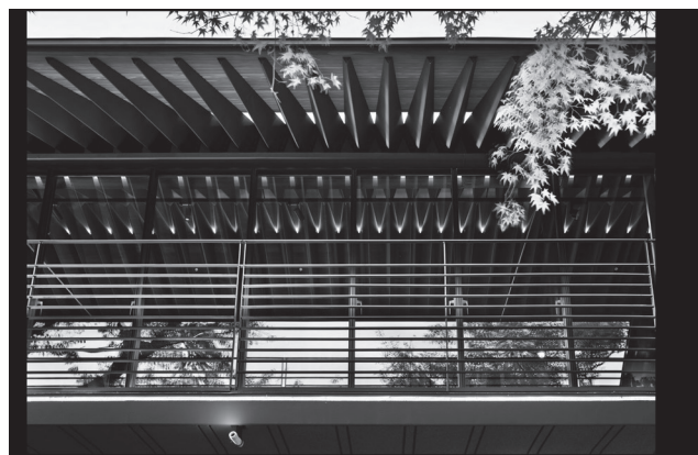
図4 3.2mmの鉄板が構造の屋根 (岡田茂吉記念館)
