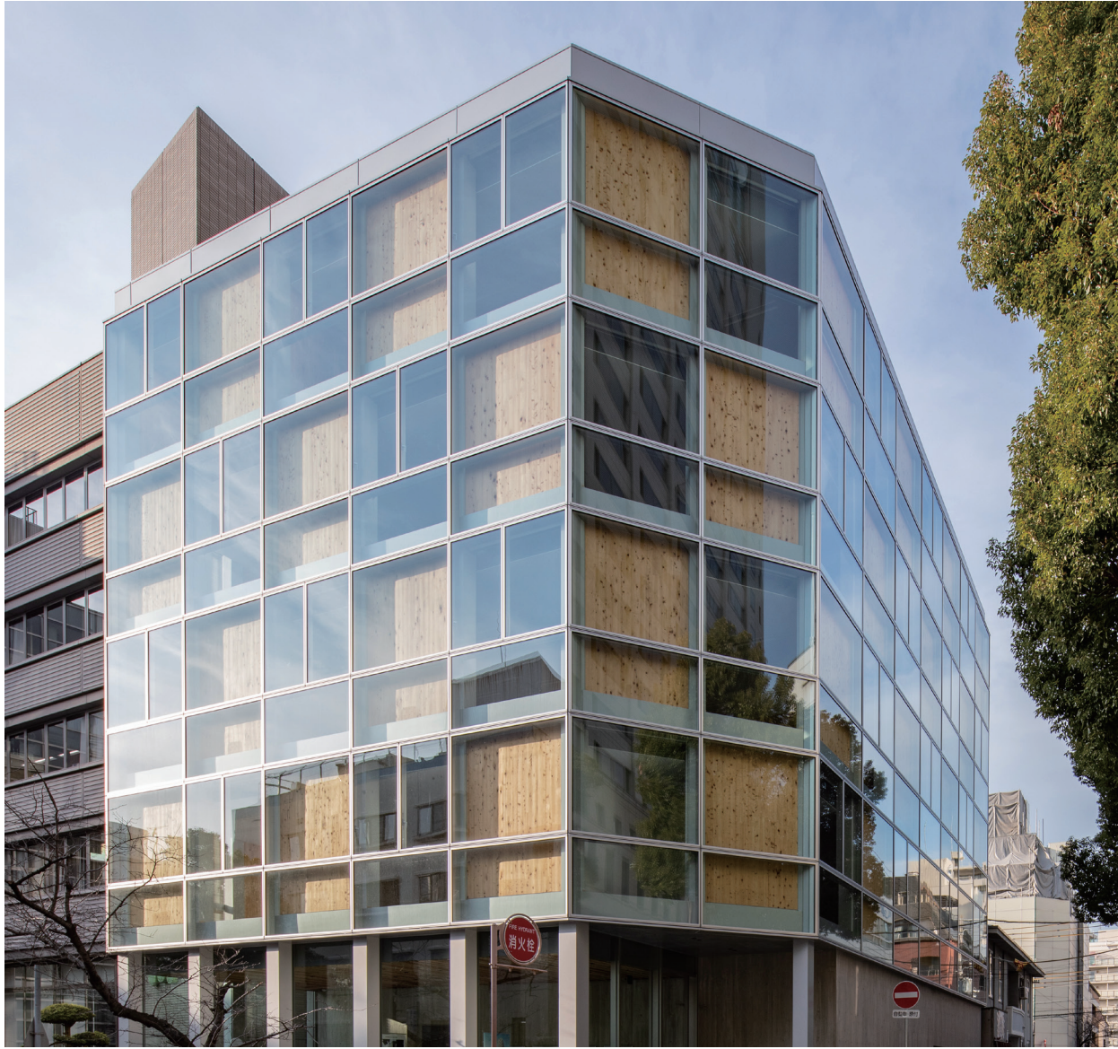
兵庫県林業会館
