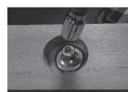
④ 電動工具でねじ締め（10~20N・m）
