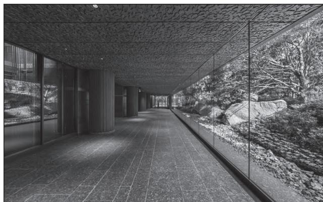
図1 原寸大デザインを起こしてつくった葉っぱのアルミキャスト（新ダイビル）
