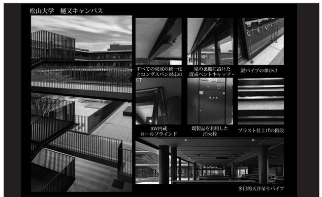
図9 材料、工法でさまざまに凝らした工夫(松山大学樋又キャンパス)
