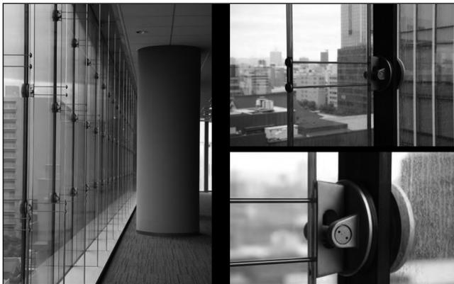
図6 ガラス方立構法+EPC工法(本町南ガーデンシティ)
