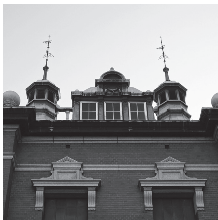
ドーマー窓と銅板造の塔屋が左右対称の美しさを強調
