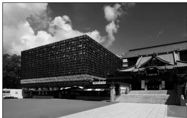
図1 深川不動堂新本堂竣工時外観（撮影：杉野 圭氏）
