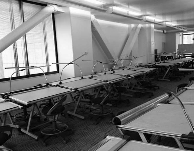
隠さずあえて露出させた制震装置
