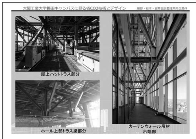
図6 ハットラスとカーテンウォール吊材の吊端部
