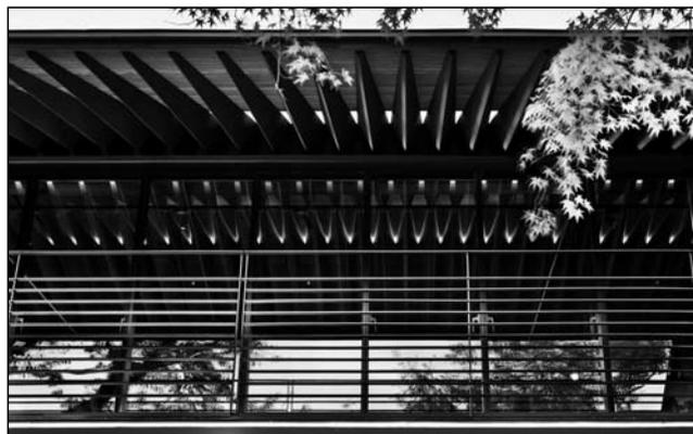
図4 3.2mmの鉄板を使った屋根(岡田茂吉記念館)
