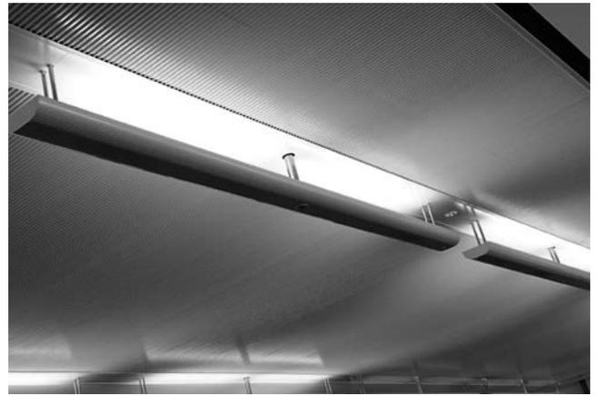
天井を照らすアンビエント照明と冷暖房天井放射パネル
