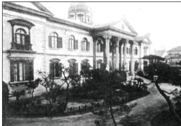
図1 旧大阪府庁舎(明治期撮影) 1)
