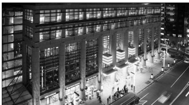
図3 日本橋三井タワーの低層部① ©三輪晃久建築写真研究所
