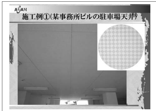
図2 施工例①(某事務所ビルの駐車場天井)
