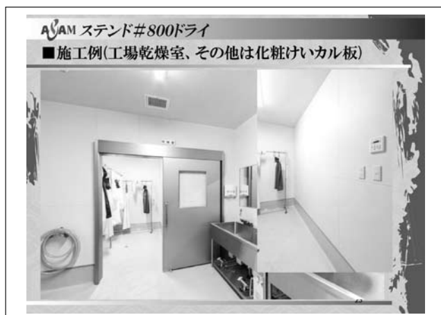
図6 施工例(工場乾燥室、その他は化粧けいカル板)
