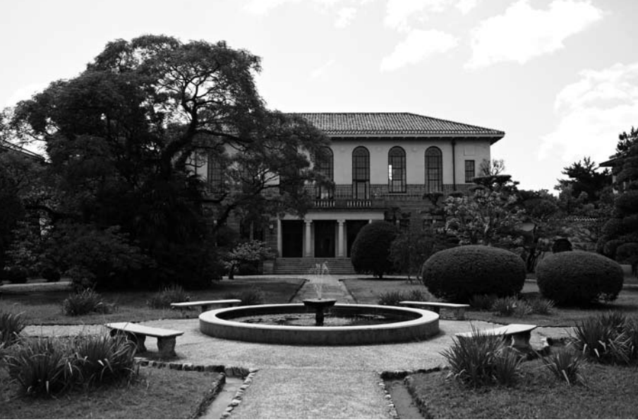
中庭を囲む校舎群の一つ、南側の図書館
